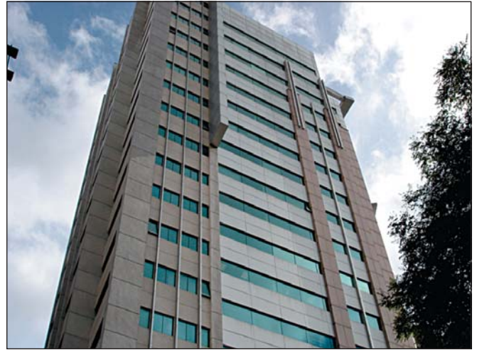
Figura 10: Compartimentação vertical de fachada
