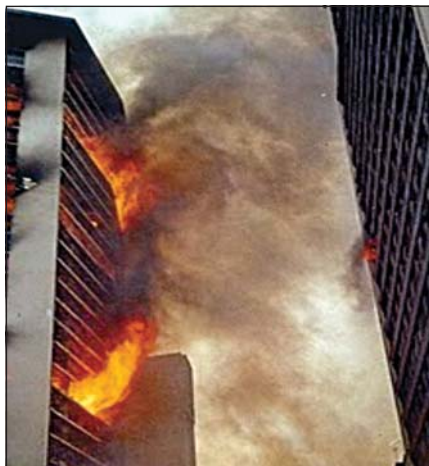
Figura 23: Propagação por convecção, onde gases quentes fazem com que ocorram focos de incêndio em andares distintos
