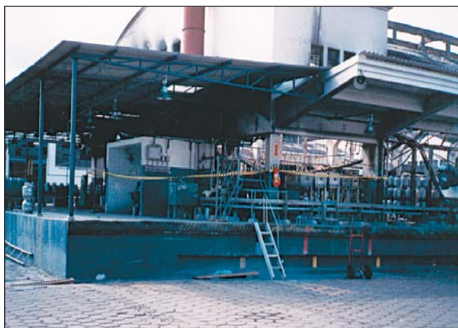
Figura 7: Isolamento do local sinistrado
