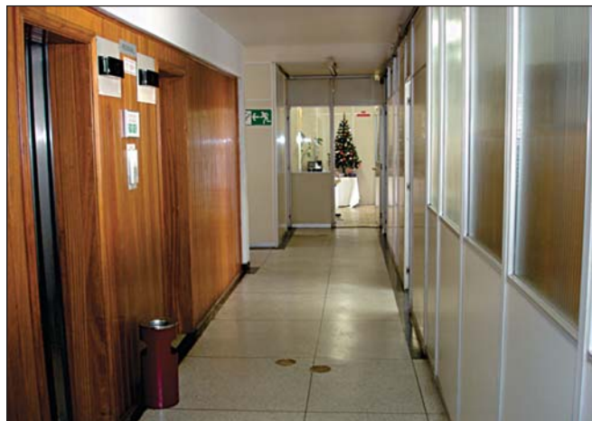
Figura 50: Corredor desobstruído e sinalizado
