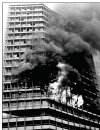
Figura 12: Incêndio no Edifício Joelma
