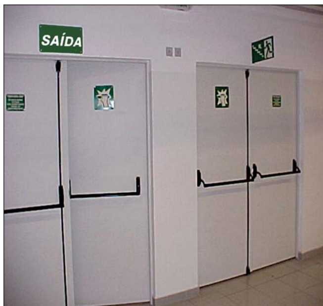
Figura 53: Porta com barra antipânico
