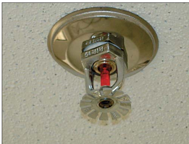
Figura 68: Chuveiro automático
