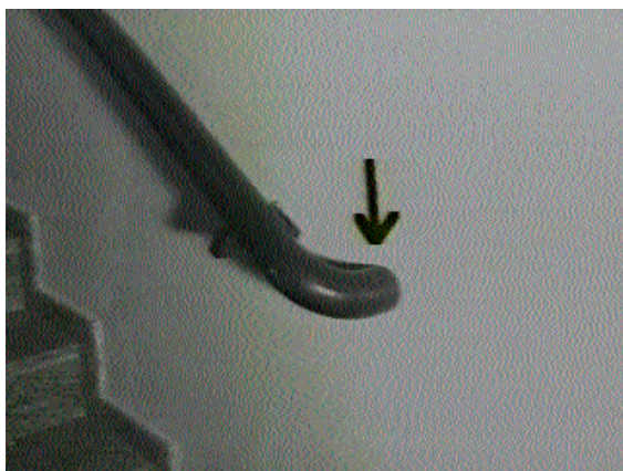
Figura 44 - Detalhe da extremidade do corrimão na parede
