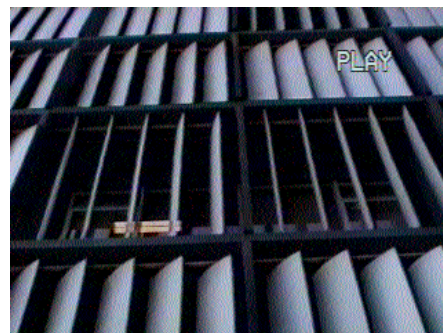
Figura 10 - Isolamento vertical de fachada
