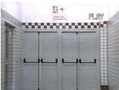
Figura 48 - Porta com barra antipânico
