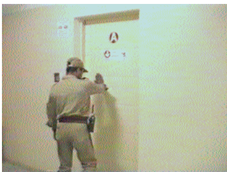
Figura 48 - Porta com barra antipânico
