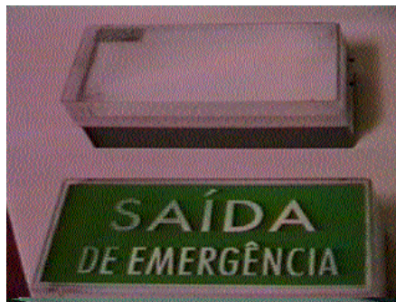
Figura 49 - Luz de aclaramento e balizamento
