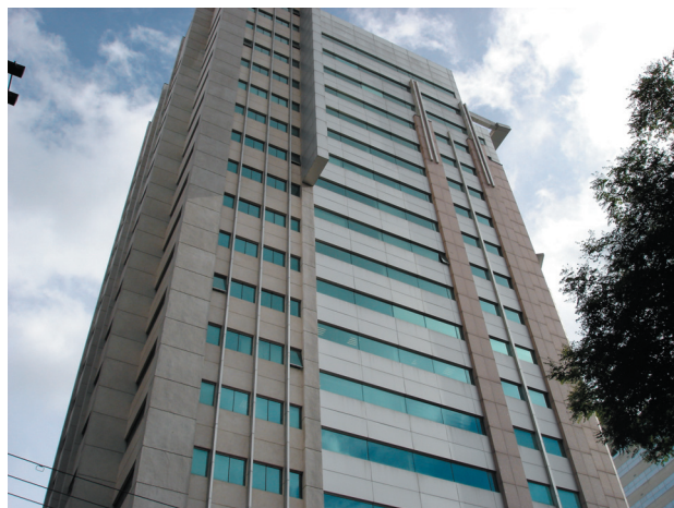
Figura 10 - Compartimentação vertical de fachada
