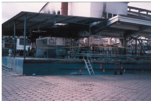
Figura 7 - Levantamento do incêndio
