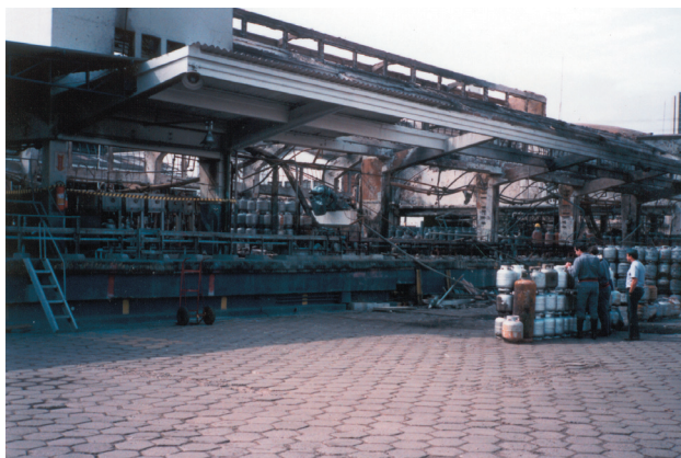
Figura 8 - Análise do incêndio por técnicos
