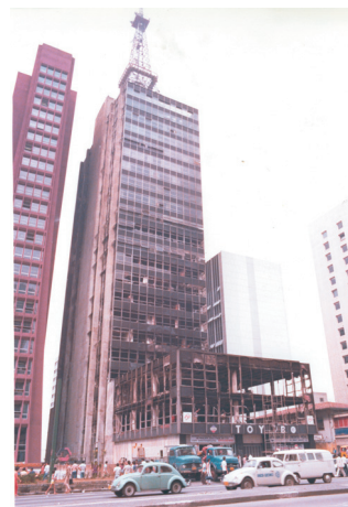
Figura 14 - Incêndio no Edifício Grande Avenida
