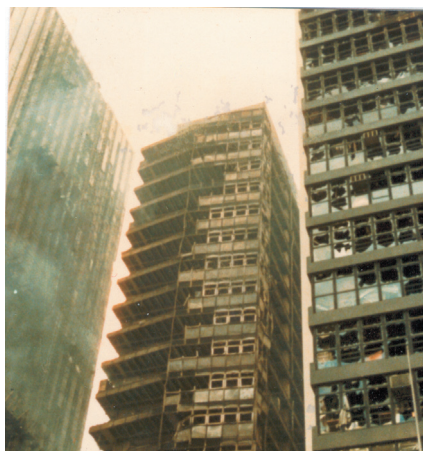
Figura 16 – Propagação entre blocos
