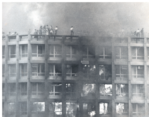
Figura 13 - Pessoas presas na cobertura
