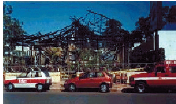
Figura 02 – Incêndio em edificação com cobertura de fibras vegetais. Ocupação de bar e restaurante.
