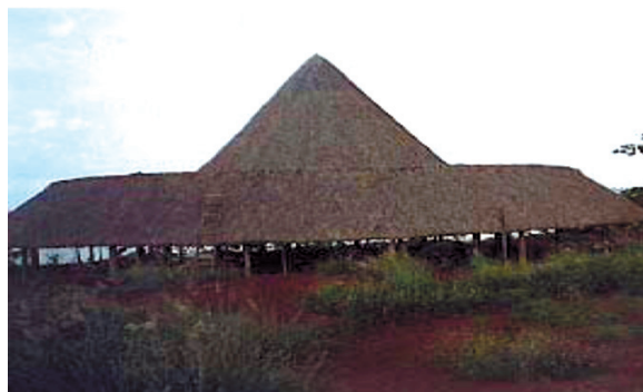
Figura 01 – Edificação de madeira com cobertura de fibras vegetais
