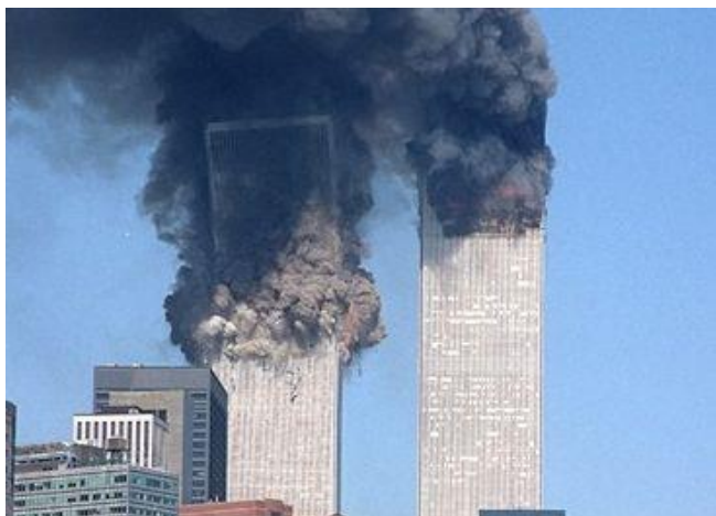
Figura 27: Colapso estrutural – World Trade Center. (Fonte: Rede mundial de computadores)
