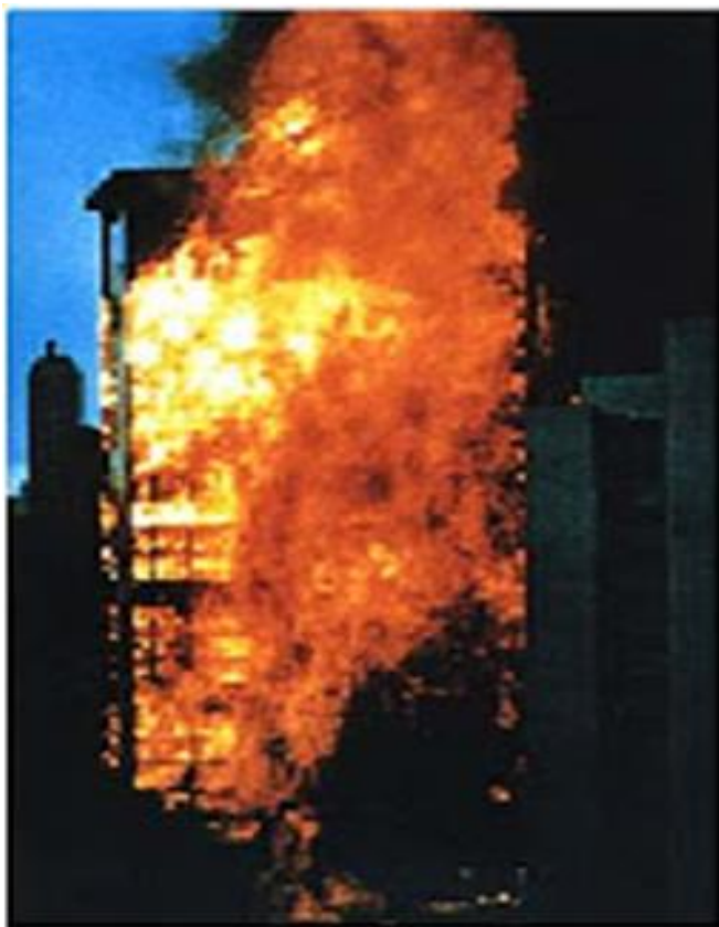
Figura 4: Incêndio no Edifício Andraus
