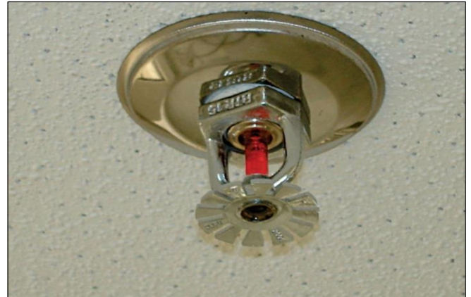
Figura 58: Chuveiro automático
