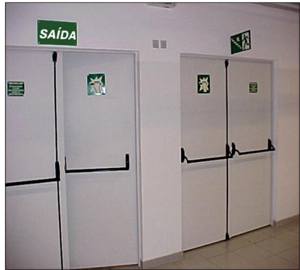
Figura 43: Porta com barra antipânico
