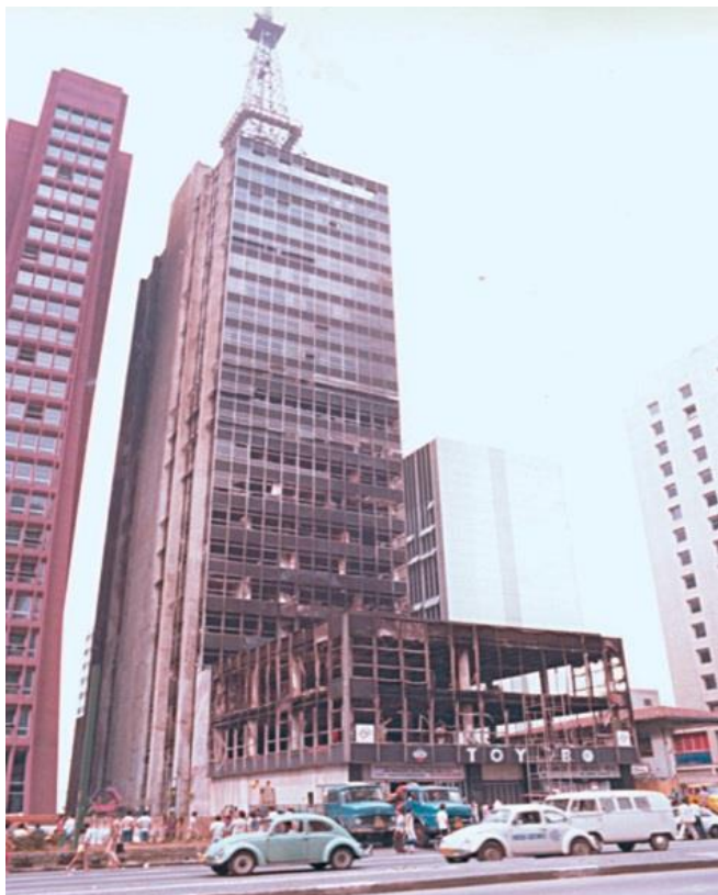
Figura 7: Incêndio no Edifício Grande Avenida
