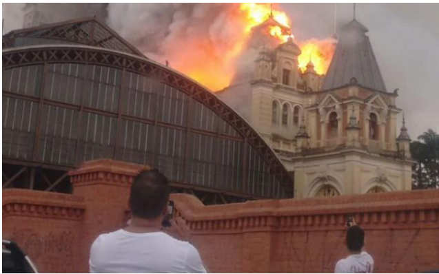
Figura 12: Incêndio no Museu da Língua Portuguesa
