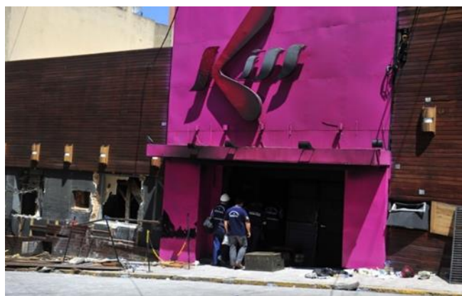
Figura 9: Incêndio em local de reunião de público (casa noturna)
