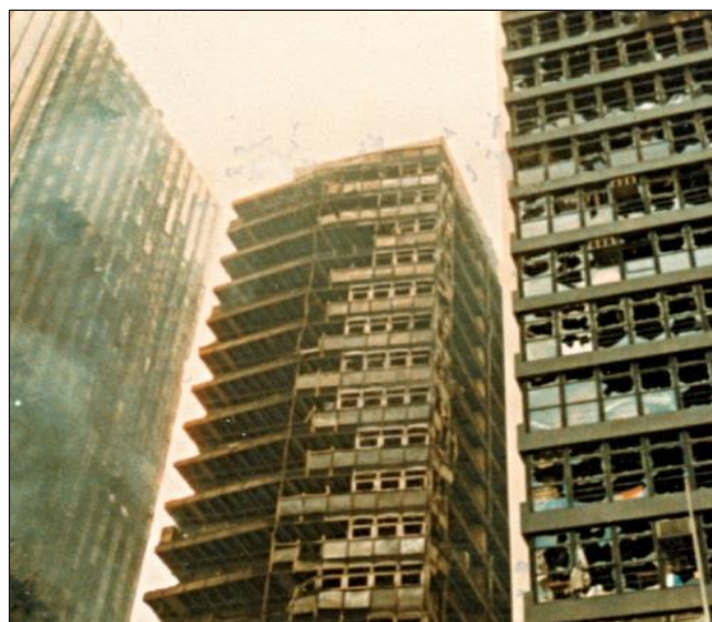
Figura 21: Radiação de calor de um edifício para outro
