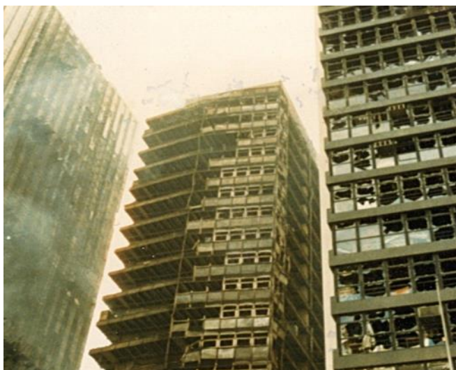
Figura 8: Propagação entre blocos
