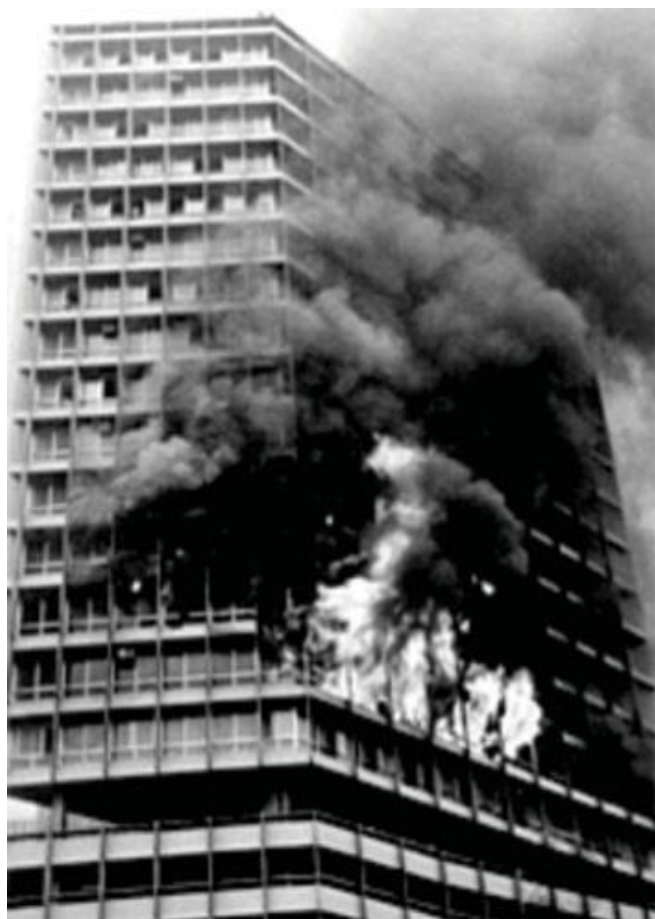
Figura 6: Incêndio no Edifício Joelma
