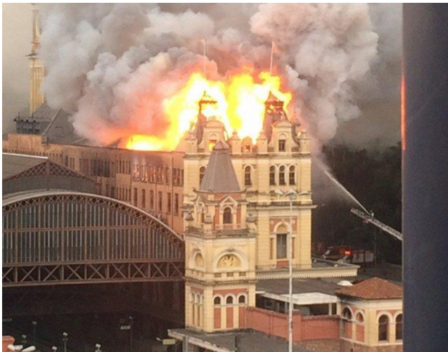
Figura 13: Incêndio no Museu da Língua Portuguesa
