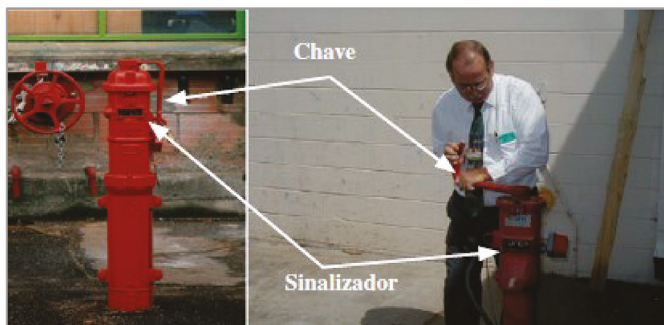
Figura 35 - Válvula indicadora de posição.
