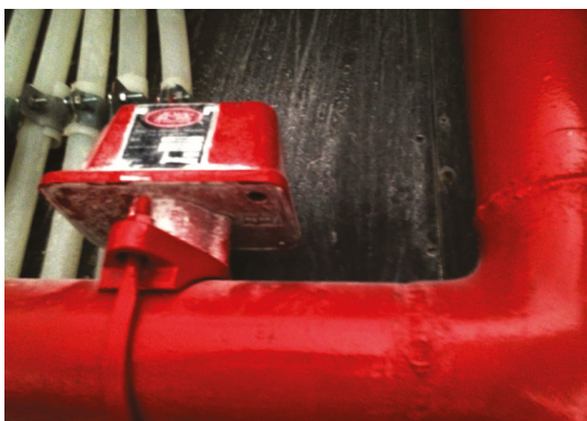
Figura 41 - Chave de fluxo sem fiação de interligação com o painel de comando.
