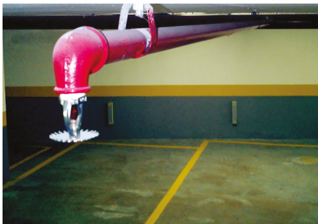
Figura 28 - Chuveiro automático tipo upright instalado em posição invertida.
