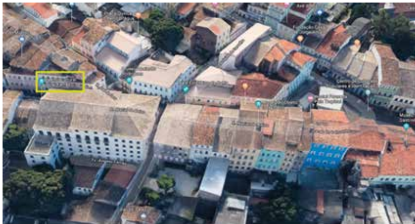
Figura 17 – Foto aérea do Pelourinho com a imagem do Centro Cultural Solar Ferrão
