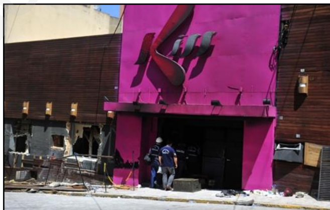
Figura 8: Incêndio em local de reunião de público (casa noturna)
