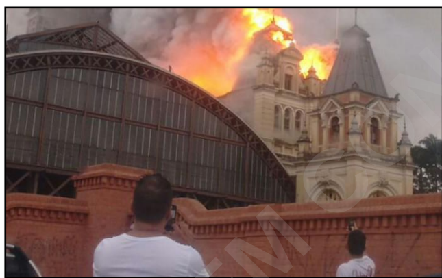
Figura 11: Incêndio no Museu da Língua Portuguesa.
