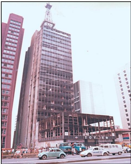
Figura 5: Incêndio no Edifício Grande Avenida.
