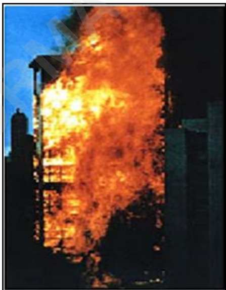
Figura 2: Incêndio no Edifício Andraus.
