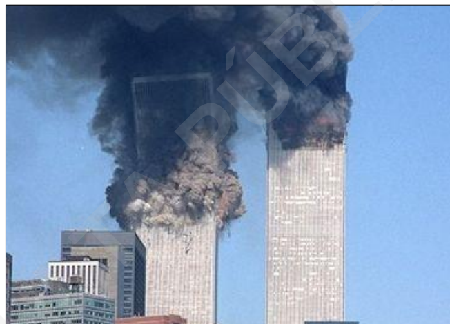
Figura 28: Colapso estrutural – World Trade Center. (Fonte: Rede mundial de computadores).
