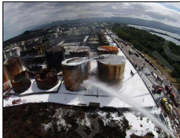
Figura 60: Incêndio em parque de tanques.
