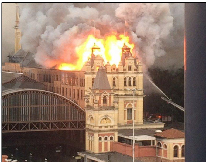
Figura 12: Incêndio no Museu da Língua Portuguesa.
