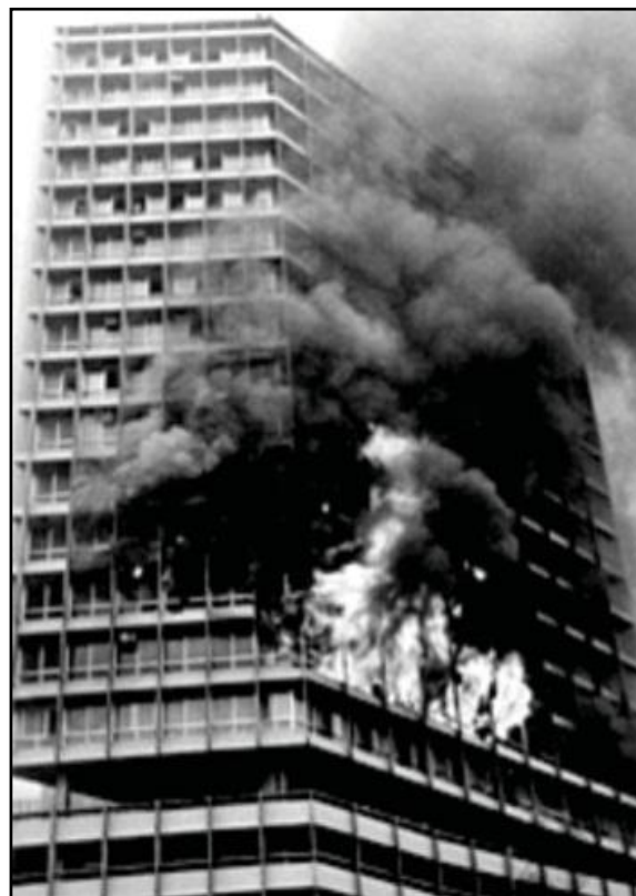
Figura 4: Incêndio no Edifício Joelma.
